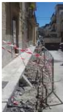
Riparazione rete idrica
